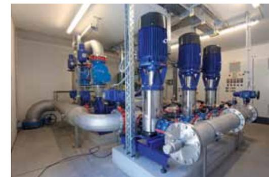
*Oben: Trinkwasser muss strengeren Richtlinien genügen als Wasser aus der Flasche. Unten: Leistungsstarke Pumpen sorgen für den richtigen Wasserdruck.*
