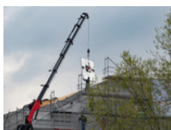
Die neuen Fenster wurden mit Hilfe eines Mobilkrans eingesetzt. Foto: Stefan Tesche-Hasenbach
