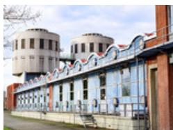
Die Verdüsungstürme prägen immer noch das Bild des Wasserwerks Benrath.
