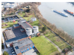
Luftbild des Wasserwerks Benrath. Das Rohwasser wird auf der gegenüber liegenden Rheinseite gefördert.
